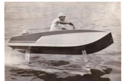
●図2 急旋回する一本脚の水中翼船
